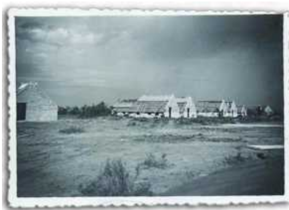
Photographie de la construction du camp, octobre 1942 (142 W 76)
